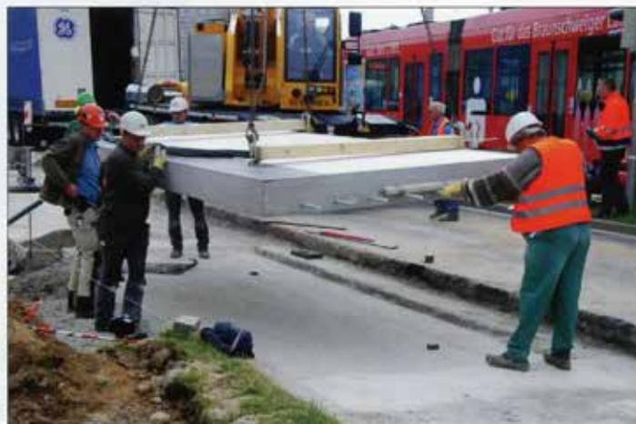
Am Hauptbahnhof wird eine der beiden Ladepplatten eingebaut
