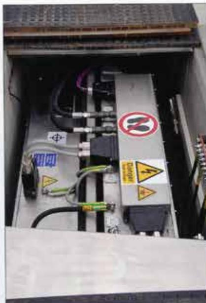
Fertigteilbox mit der „primären Leistungselektronik“ einer Ladestation im Fußweg am Hauptbahnhof
