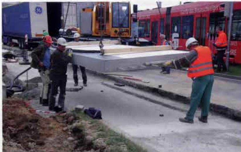
Bild 2: Am Hauptbahnhof wird eine der beiden Ladeplatten eingebaut
