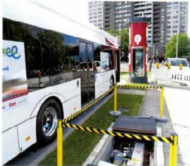
Vorn die primäre Leistungselektronik, die den Gleichstrom aus dem Unterwerk in Wechselstrom zur Abgabe an die Ladeplatte umwandelt.
