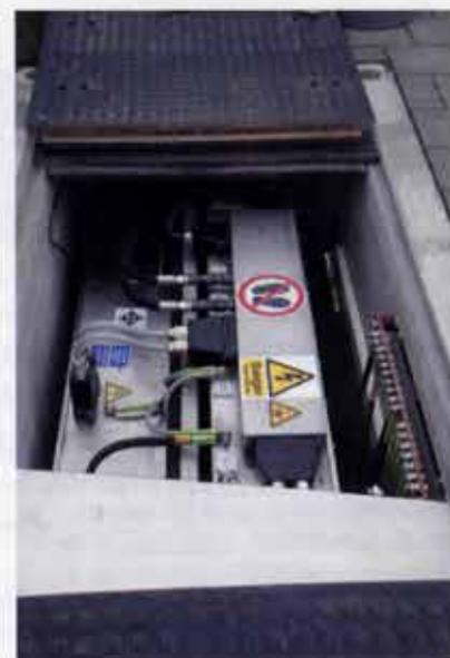
Bild 6: Fertigteilbox mit der „primären Leistungselektronik“ im Fußweg am Hauptbahnhof
