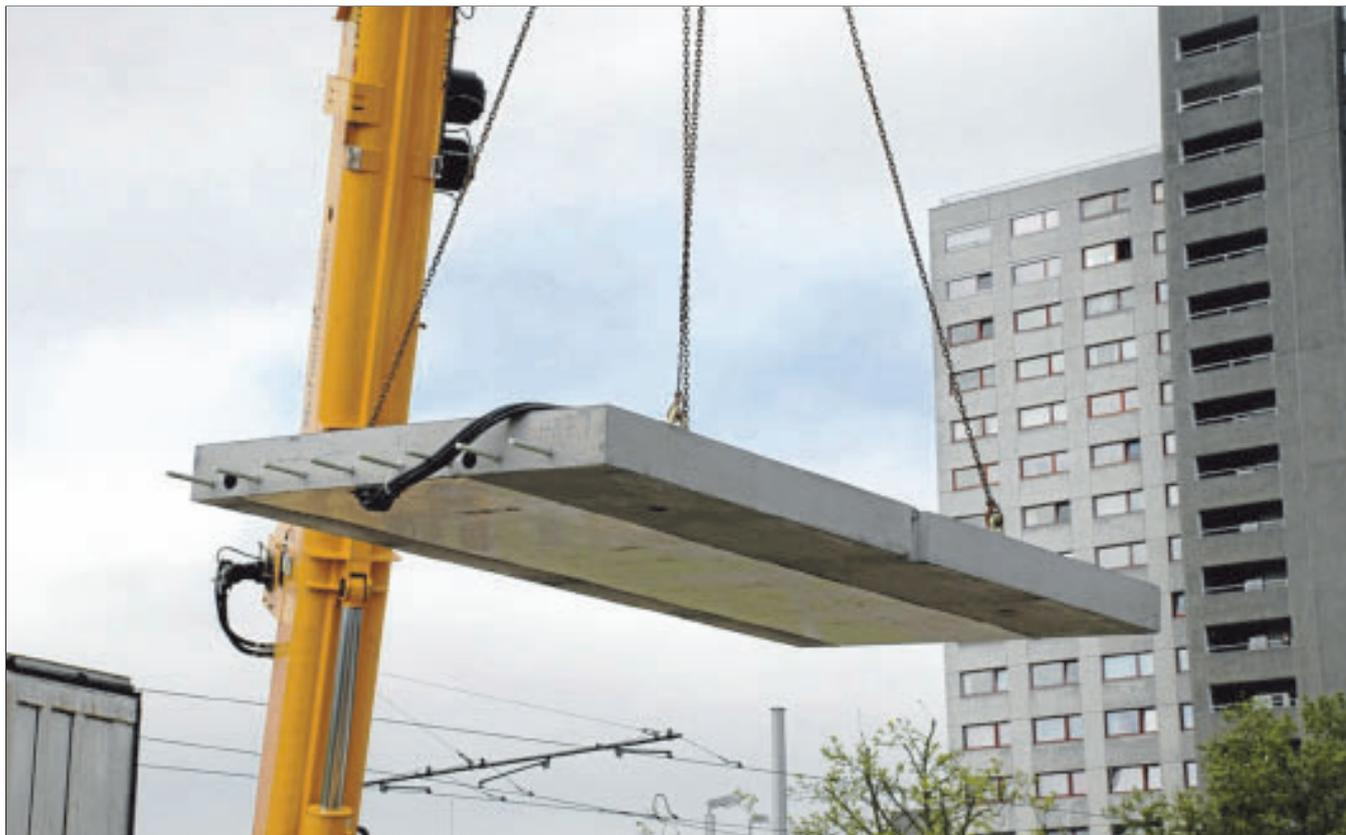
An einem großen Kran „schwebte“ die vier Tonnen schwere Ladestation über der Busspur am Hauptbahnhof und wurde dann zentimetergenau in die vorbereitete Grube eingepasst. Fotos (2): Verkehrs-AG/oh
