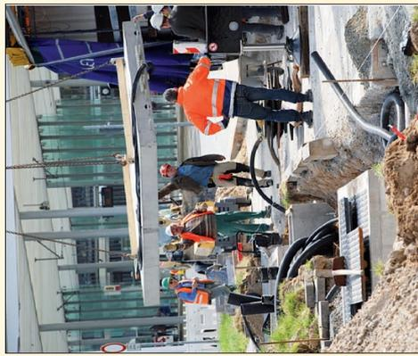
An der Endhaltestelle der M19 am Braunschweiger Hauptbahnhof erfolgte jetzt der Einbau der ersten induktiven Ladestation im öffentlichen Raum.
